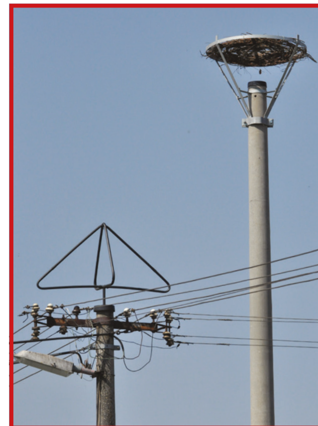
(35) Nová hniezdna podložka na samostatnom stĺpe a odpudzovač na elektrickom stĺpe, kde stálo hniezdo
